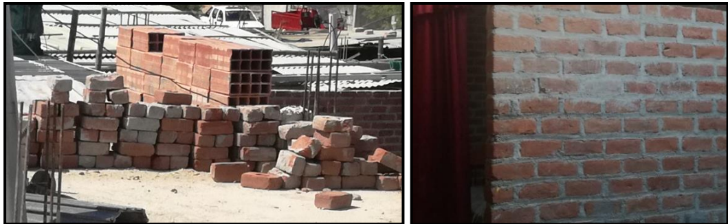
Figura 4. 4. Ladrillo artesanal empleados en la construcción de muros.
