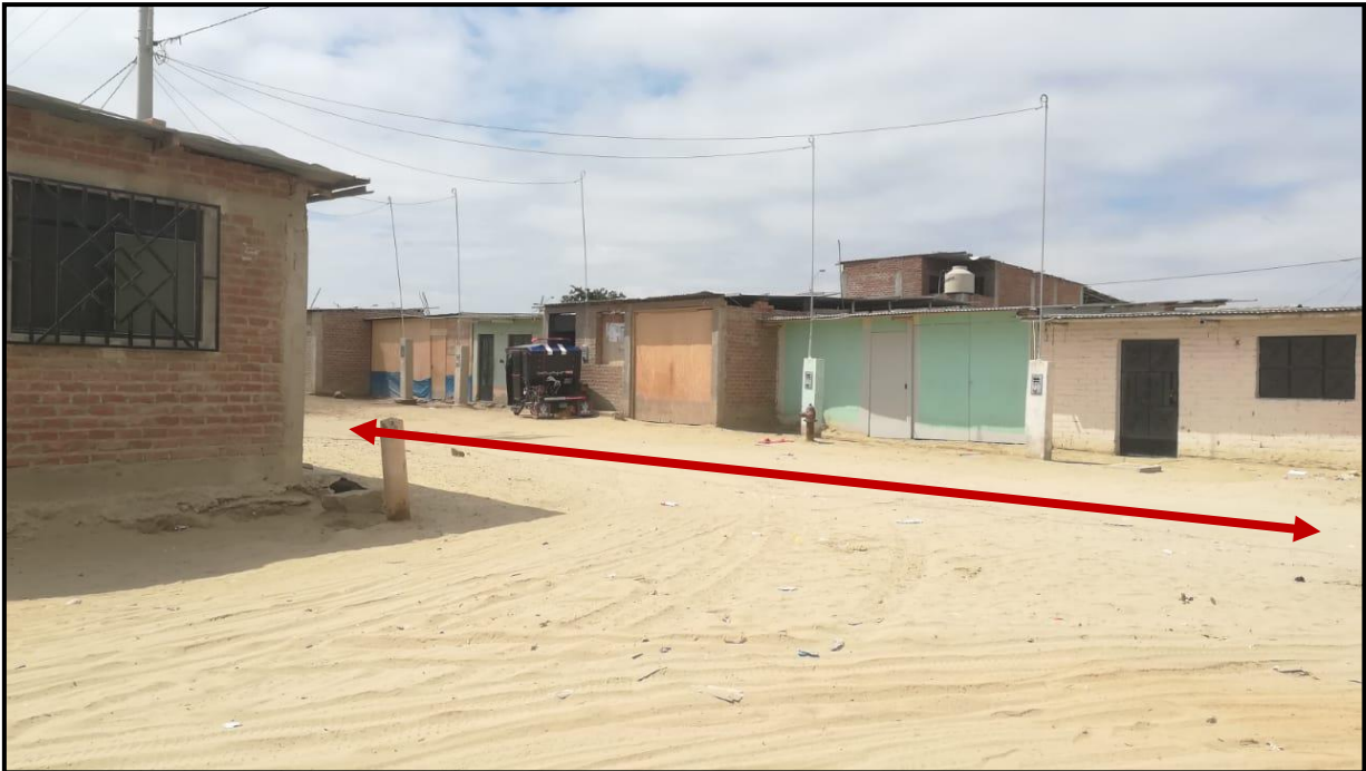
Figura 1. 3. Calle 4 del Asentamiento Humano Los Angeles.
