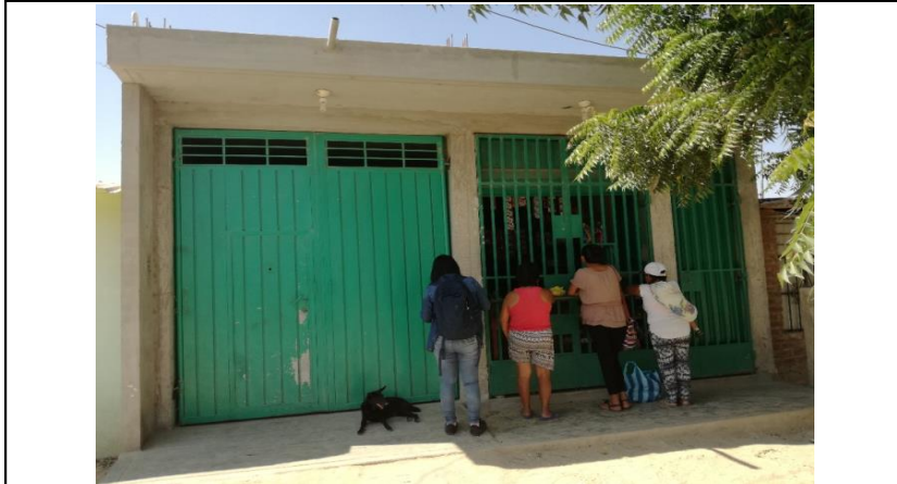
Foto de Fachada
