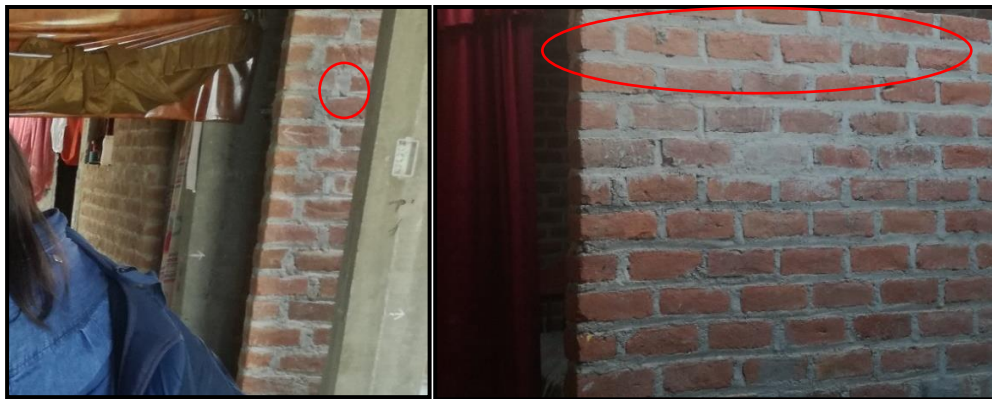
Figura 4. 6. Juntas de espesor de hasta 5cm.
